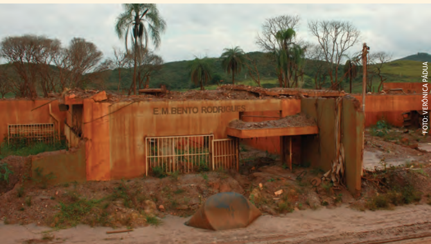
Escola Municipal de Bento Rodrigues destruída pela lama
